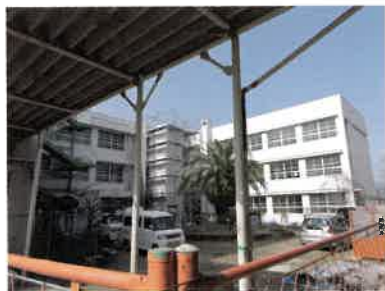
佐野台小学校のエレベーター設置工事
