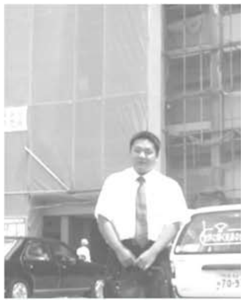
松原住宅建て替え工事を視察(6/27)
